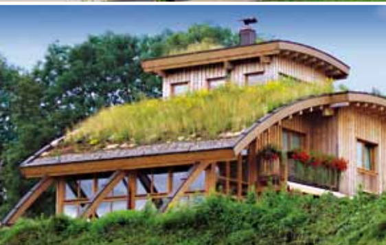
Végétalisation extensive de toit à forte pente
