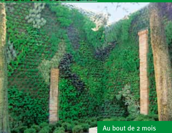
Après la mise en place
