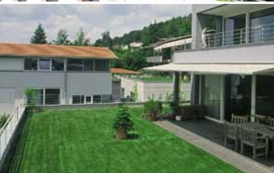
Végétalisation intensive de toiture avec gazon praticable
