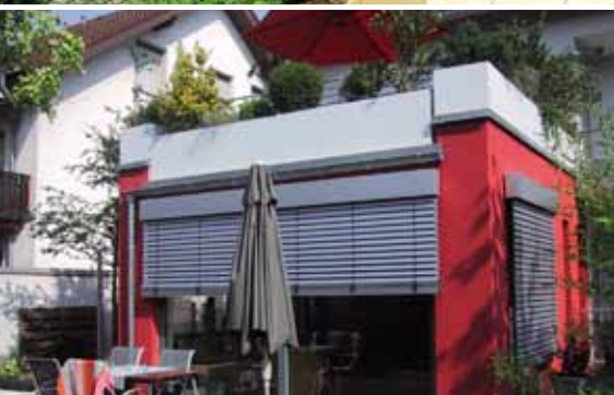
Bacs à plantes intégrés à la bordure du toit avec garde-fou
